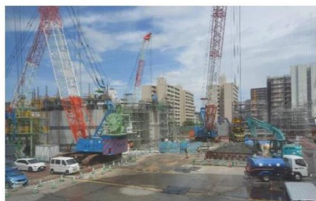
工事現場には巨大な重機が！
