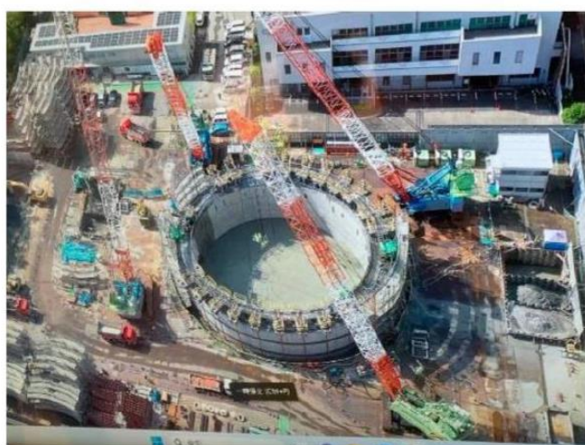
真上から撮影した立坑工事現場
