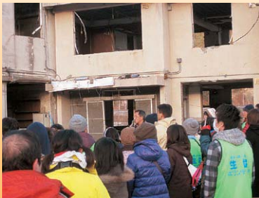
←壊れたままの大槌町役場
