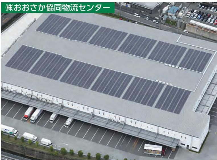
再生可能エネルギーはCO<sub>2</sub>の排出量を大幅に削減し、日本のエネルギー自給率を上げることにつながります。現在、パルコープでは(株)おおさか協同物流センター(655kW)を含めて925kWの太陽光発電が稼働しています。年間発電量は合計864,632kWhとなり、CO<sub>2</sub>の排出量で約366トンの削減につながっています。
