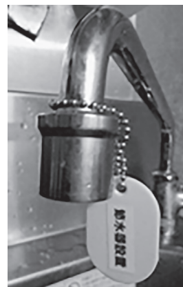
◀節水蛇口 従来の節水とは違い、水に空気をまぜることで、使用感を良くしながら、水量を削減します。
